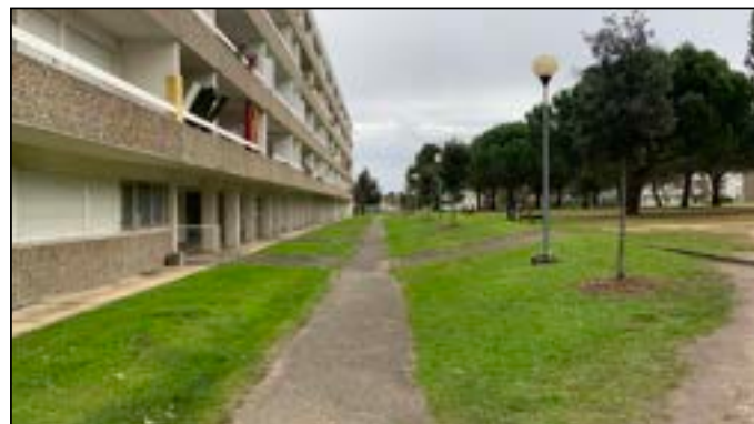
Dénivelé non PMR au centre du quartier.
