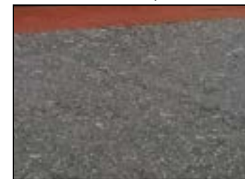
Béton désactivé des aires de jeu.
